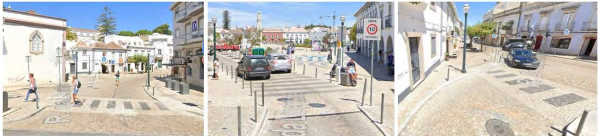
Figure 4.36 - Entrance to the coexistence zone at Rua da Liberdade and Praça da República
