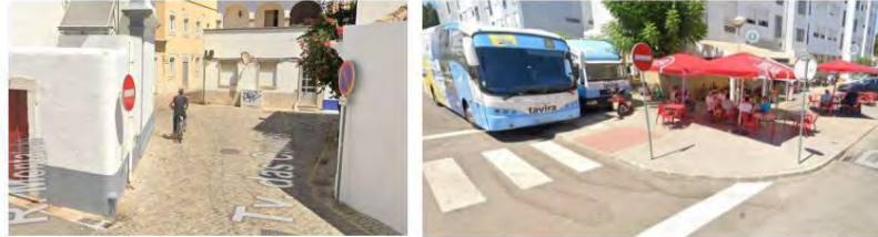
Figure 4.46 - Areas to be intervened - Rua das Comunidades Lusíadas/ Rua do Poço do Bispo/ Travessa das Cunhas
